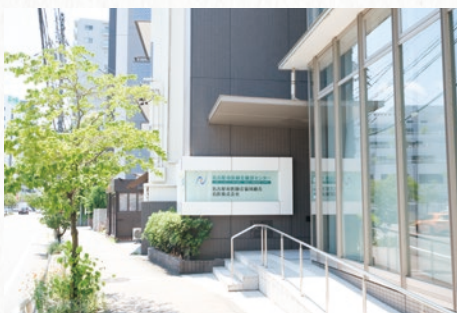
健診センター入口(東側玄関)
